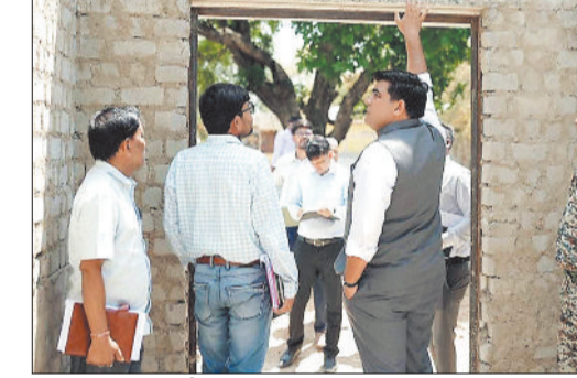
निर्माण कार्य का निरीक्षण करते कलेक्टर एवं अन्य।
